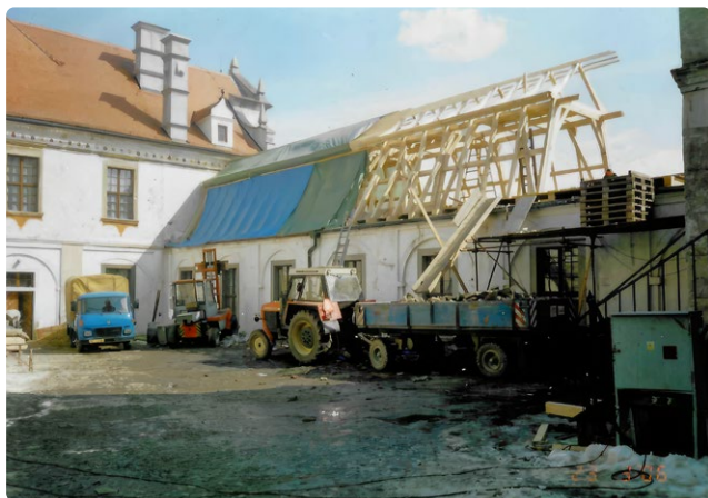
Budování nové střechy nad terasou roku 2005
