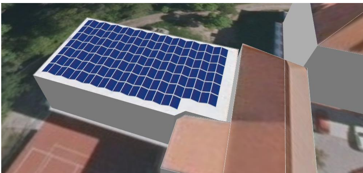
Obrázek 19 Navržená FVE 66,9 kWp – detail instalace na budově tělocvičny
